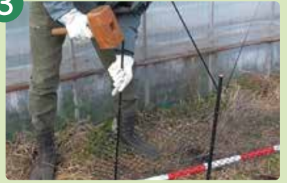
ネットにポールを差し込み
